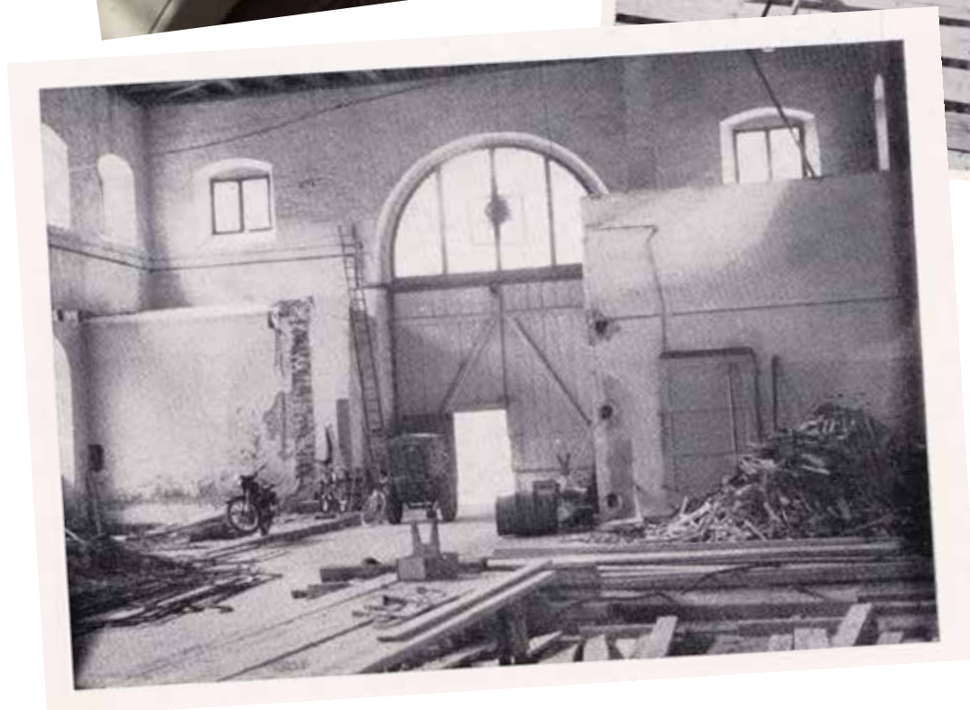
Umbau des „Neubaus“ (ehemalige Zollhalle), 1963
