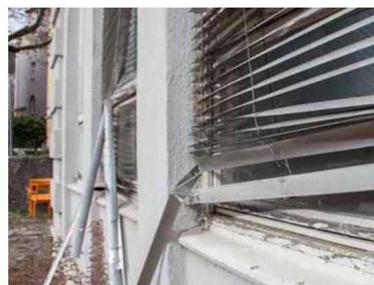
Defekte Jalousien an der Südfassade
