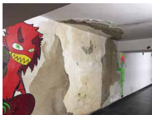
Feuchtigkeitsschaden im Tunnel
